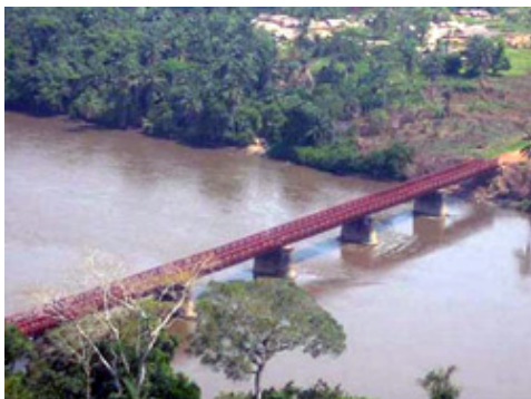
Un pont près de Bafwasende, RDC: la plupart des infrastructures du pays sont dans un état de détérioration avancé.
